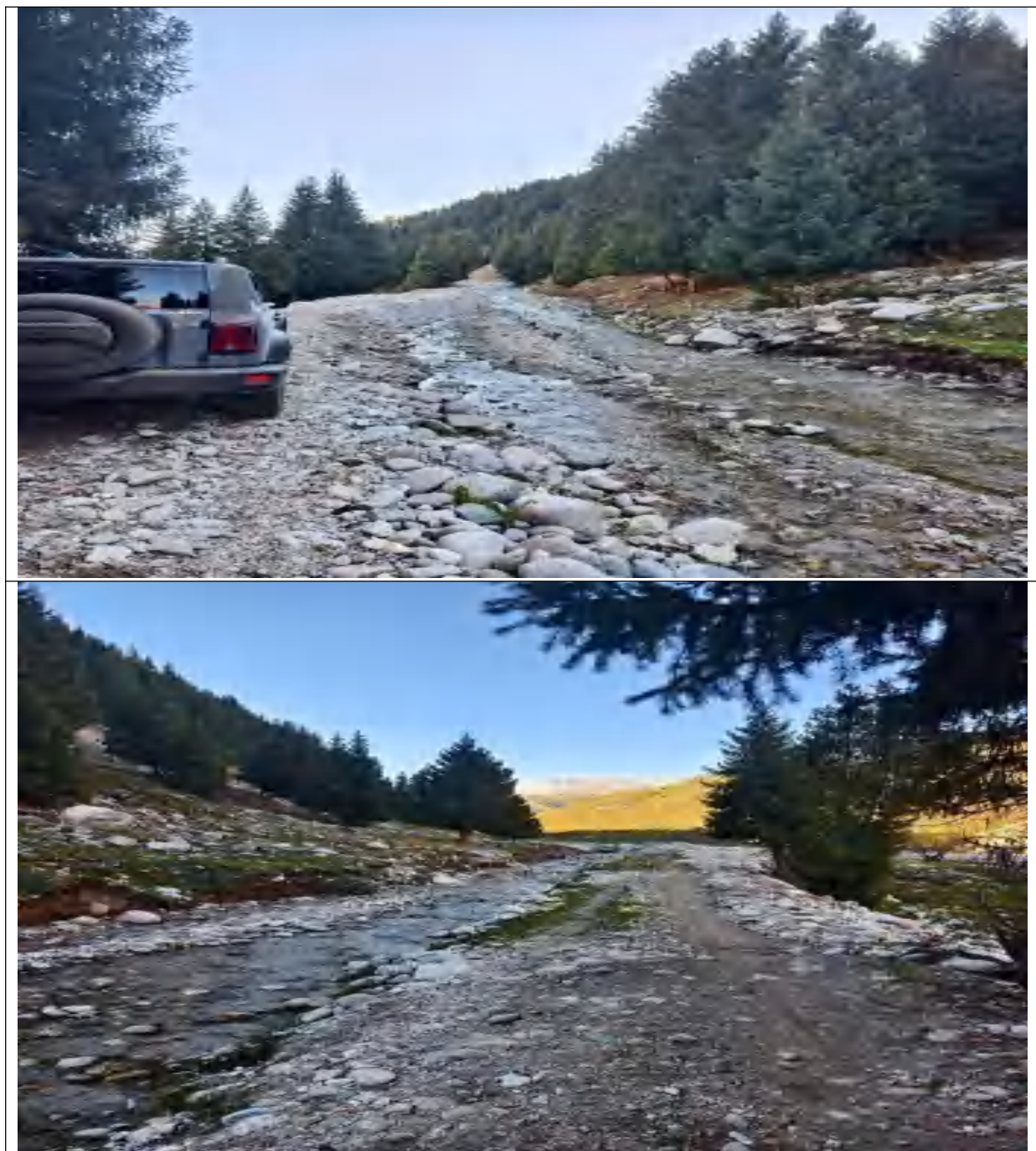
图 4.3-4 引水渠道实景
