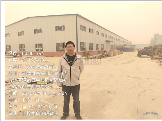
项目厂区车间现状
