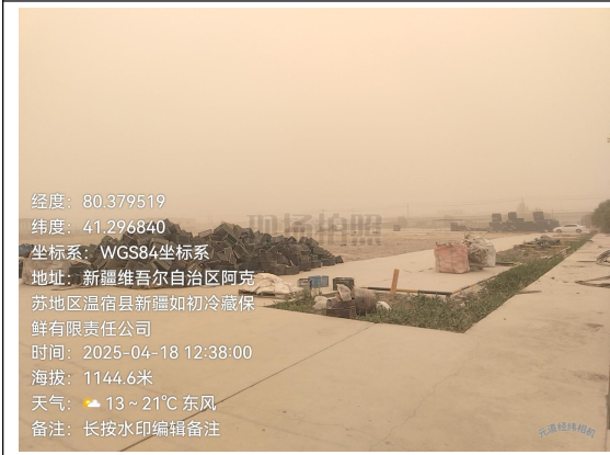
厂区南部现状
