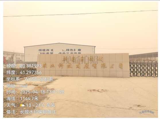
厂区东部现状
